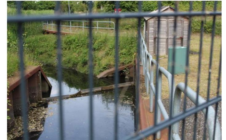
Tauchwand mit Wasserpumpe
